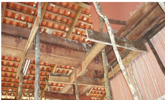
Figura 6 – Fôrmas e escoras.
