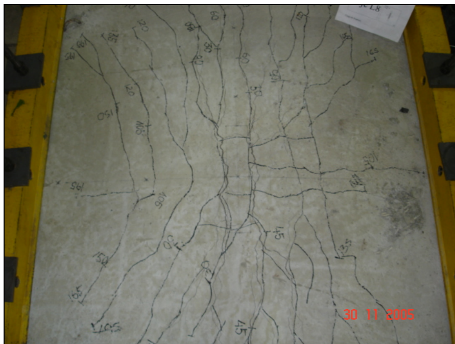
Figura 4.47 – Mapa de fissuração da laje L8
