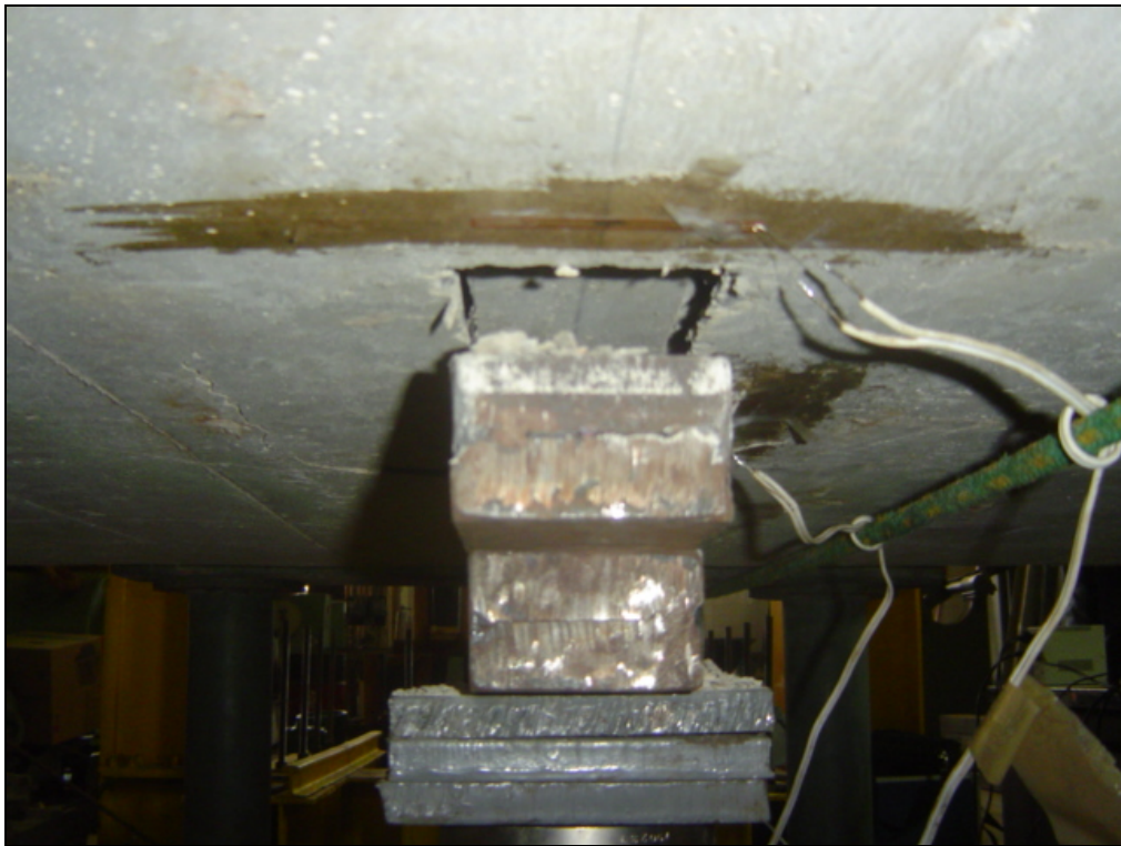
Figura 4.23 – Posicionamento dos extensômetros do concreto na superfície inferior da laje
