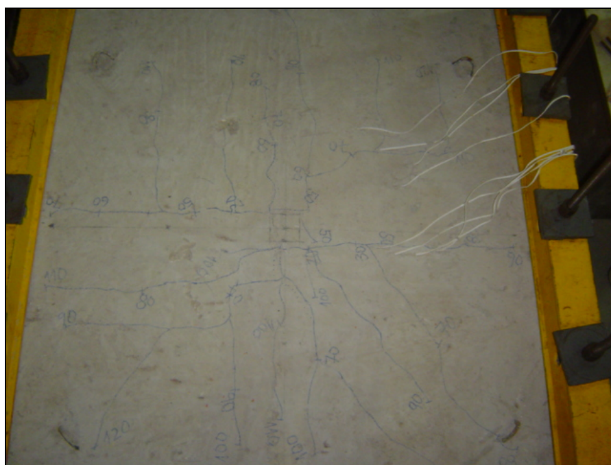
Figura 4.40 – Mapa de fissuração da laje L1
