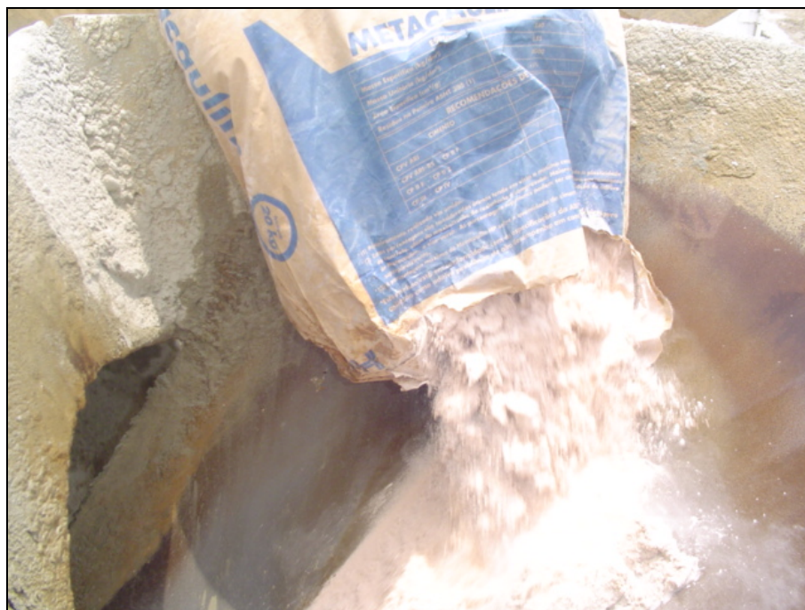
Figura 3.27 – Adição do metacaulim no concreto
