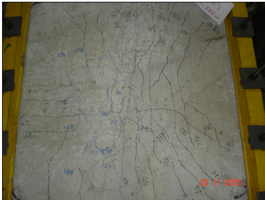
Figura 4.45 – Mapa de fissuração da laje L6
