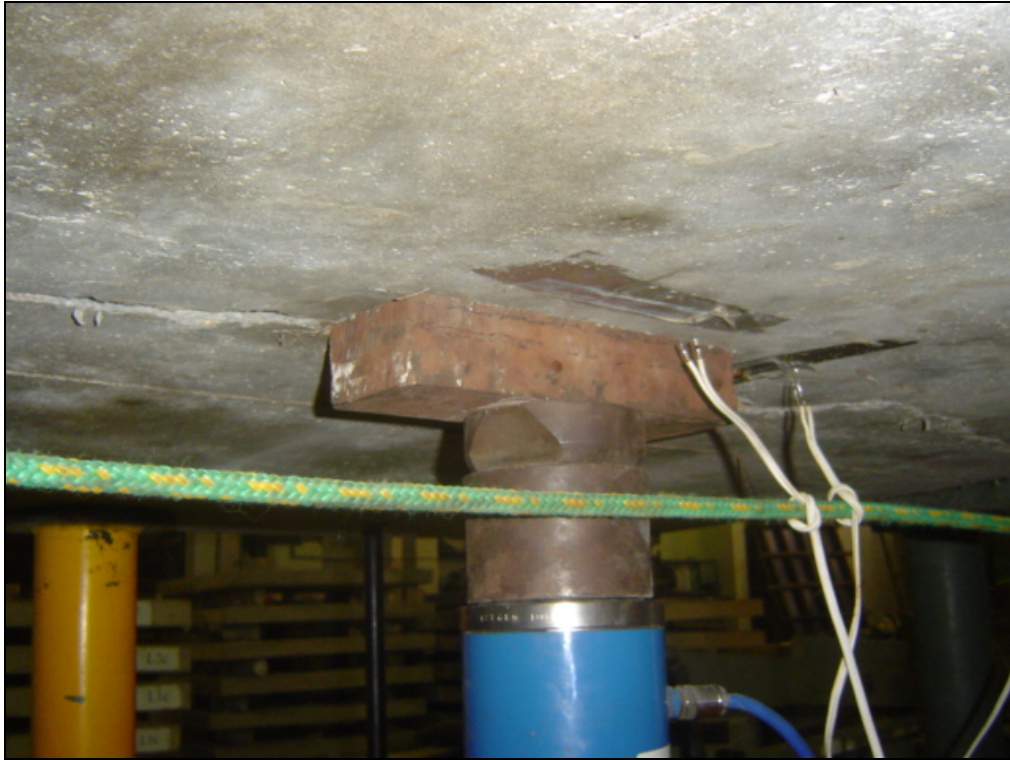
Figura 3.5 – Posição dos extensômetros do concreto
