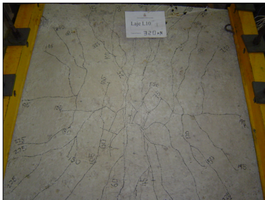
Figura 4.49– Mapa de fissuração da laje L10
