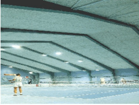
FIGURA 2.3 – Forro de quadra esportiva
