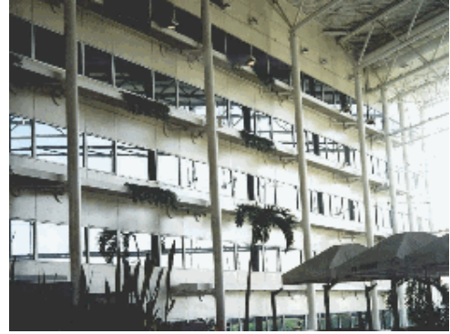
FIGURA 2.4 – Fechamento de prédio
