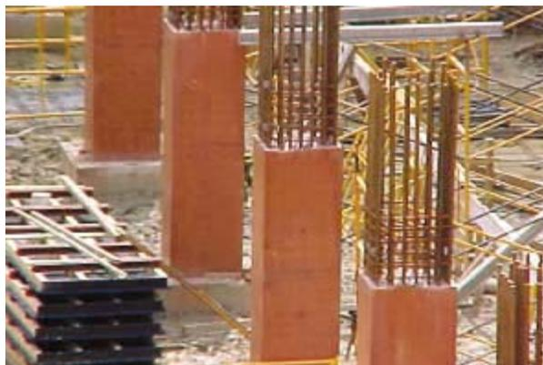
**Figura 3.15:** Os cinco pilares do Edifício e-Tower, São Paulo, onde se lançou mão do concreto colorido de alto desempenho (HELENE e HARTMANN, 2003).
