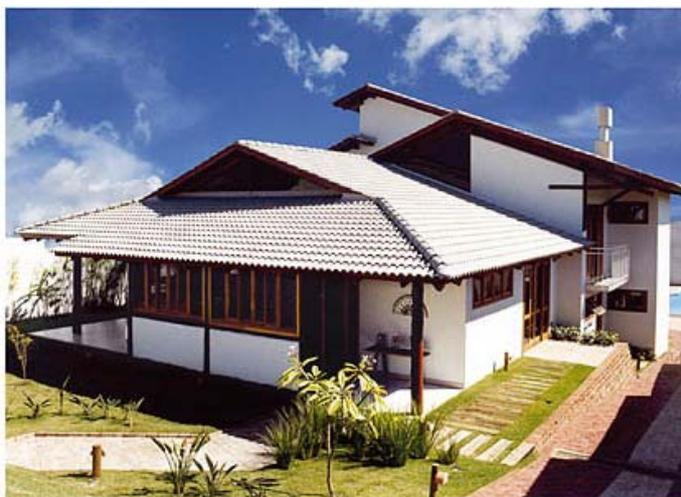
**Figura 3.13:** Exemplo de telhas em concreto colorido.
