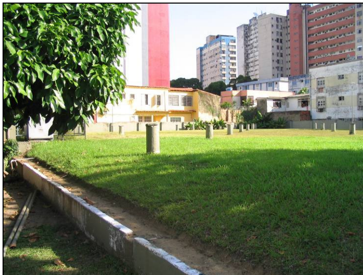
Fotografia 8 - Reservatório apoiado do 3º setor de abastecimento de água da Zona Central
