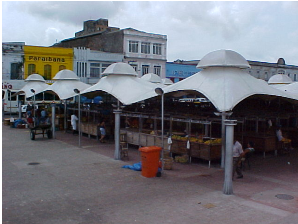
Figura 5.13 - Tensoestruturas da feira do Ver-o-Peso, alguns meses após a inauguração (foto datada de 01/01/2003).
