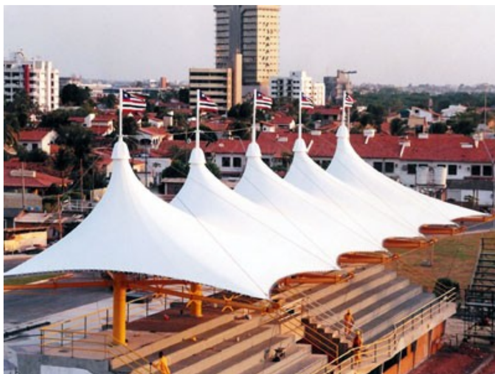
Figura 2.27 - Tensoestrutura de 680m 2 na Lagoa de Jansen em S. Luiz (MA). Fonte: ARCOWEB (2002).
