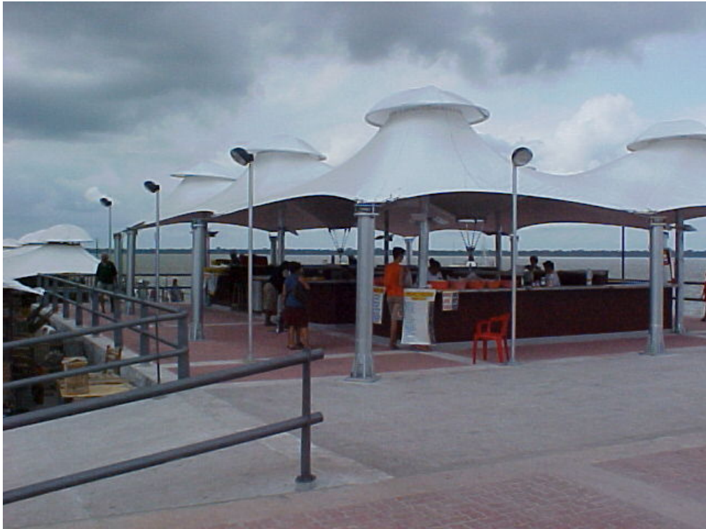
Figura 5.3 – Tensoestruturas utilizadas na reforma do Ver-O-Peso.
