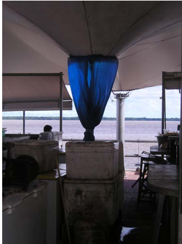
Figura 5.11 - Colocação de plástico pelos feirantes, na abertura existente na cobertura para descida das águas das chuvas (foto datada de 01/05/ 2005).
