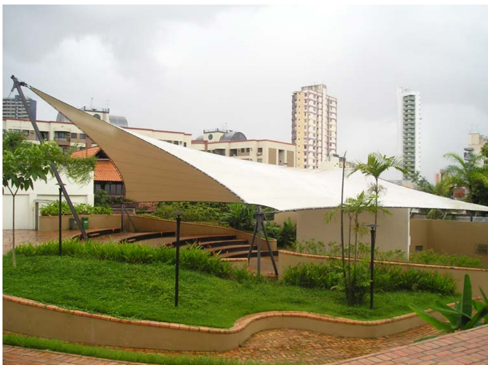
Figura 2.28 - Tensoestrutura do Memorial dos Povos – Belém-Pa (2005).
