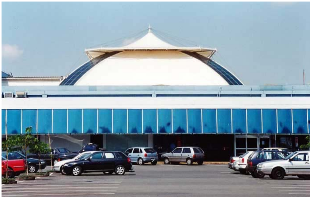
Figura 2.21 - Shopping Center de Piracicaba (SP) após concluída a montagem da estrutura.
