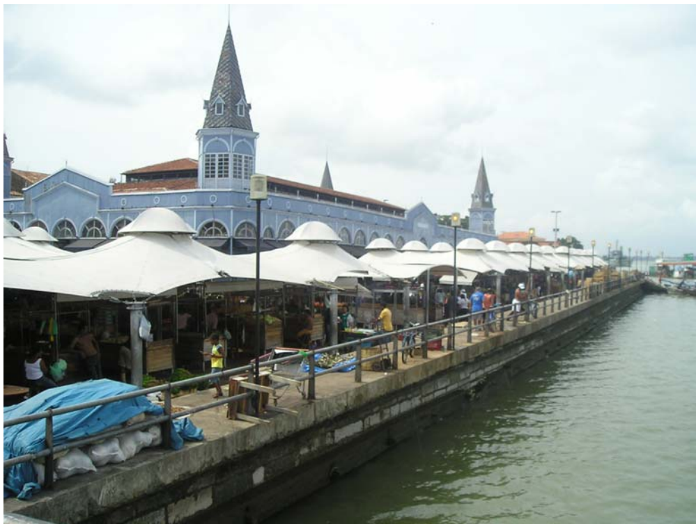
Figura 5.4 - Feira do Ver-O-Peso após a reforma, com vista do Mercado de Ferro ao fundo .
