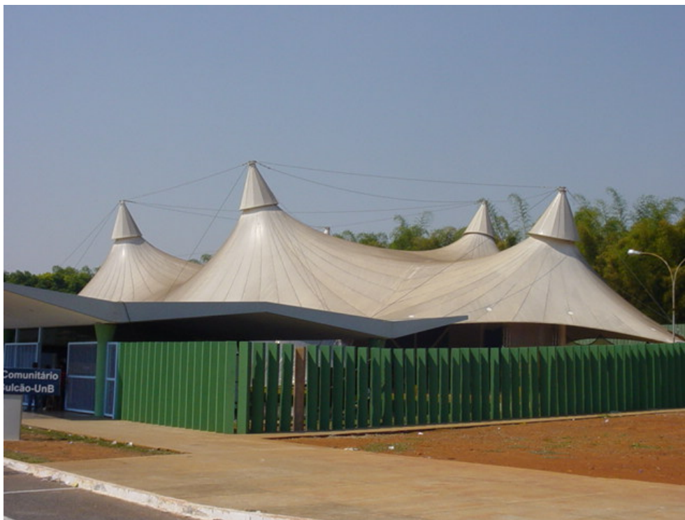
Figura 2.26- Tensoestrutura UnB-DF (26/09/2003). Cortesia: Prof. Dênio Raman.
