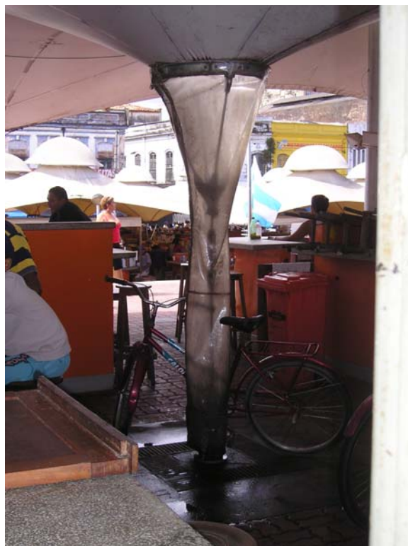
Figura 5.10 – Colocação de plástico pelos feirantes, na abertura existente na cobertura para descida das águas das chuvas (foto datada de 01/05/ 2005).
