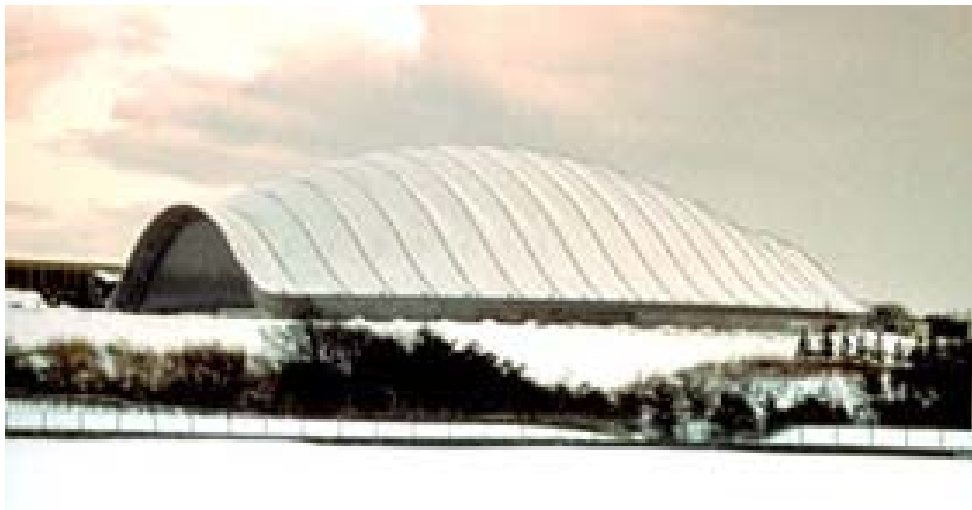
Figura 2.19 – Estádio de Akita (Japão). Fonte: KAJIMA (1990)
