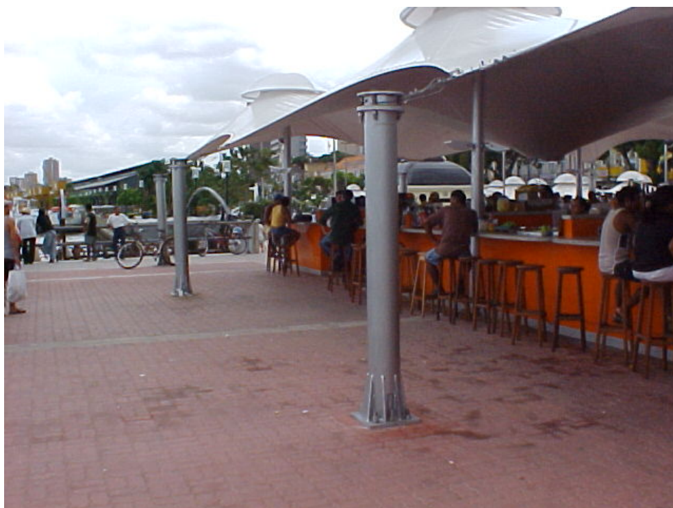
Figura 5.5 – Pilares periféricos (foto datada de 25/10/2003).
