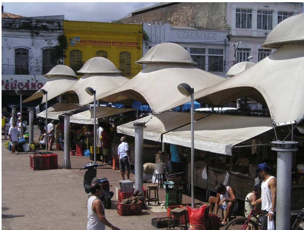
Figura 5.14 – Tensoestruturas, da feira do Ver-o-Peso, e os toldos instalados pela prefeitura (foto datada de 01/05/ 2005).
