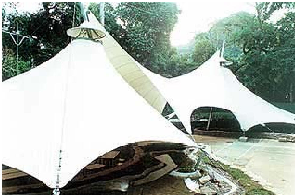
Figura 2.25 – Tensoestrutura para proteção de salas de aulas – PUC (RJ). Fonte: ARCOWEB (2004)
