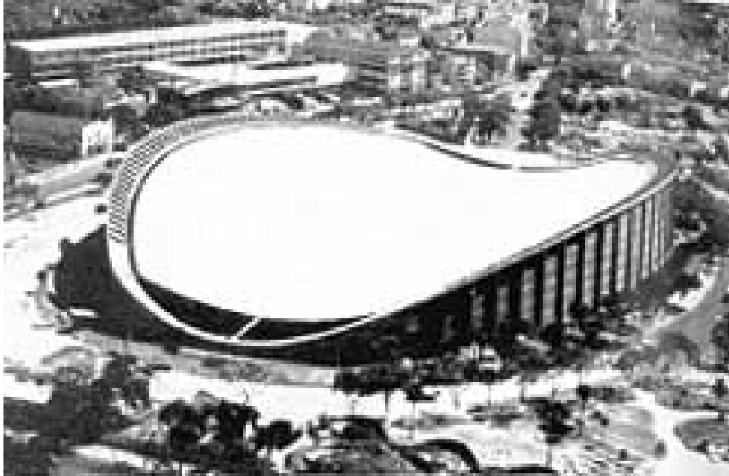
Figura 2.33 - Pavilhão de São Cristóvão (1960). Fonte: ARCOWEB (2002).
