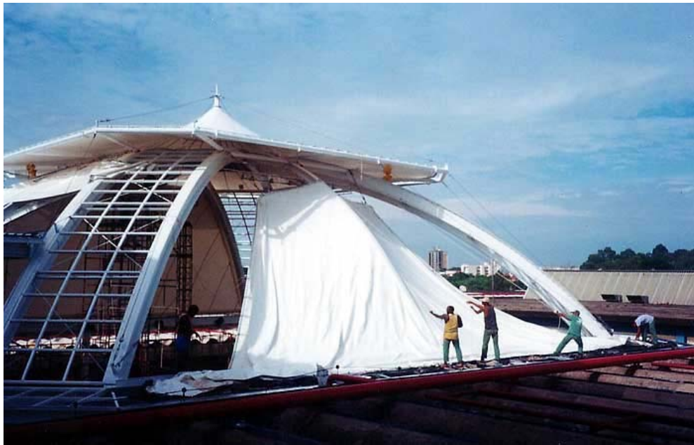
Figura 2.20 – Shopping Center de Piracicaba (SP) durante a montagem da estrutura.
