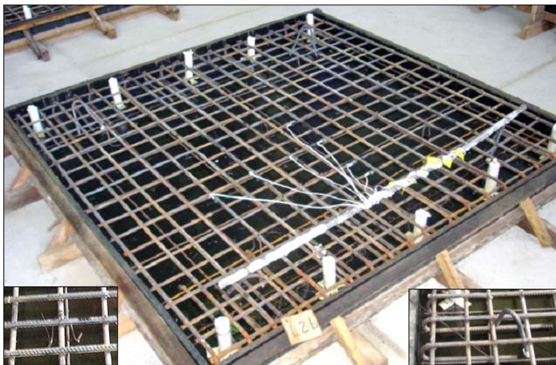
Figura 3.5b – Armadura da laje L2b posicionada na fôrma
