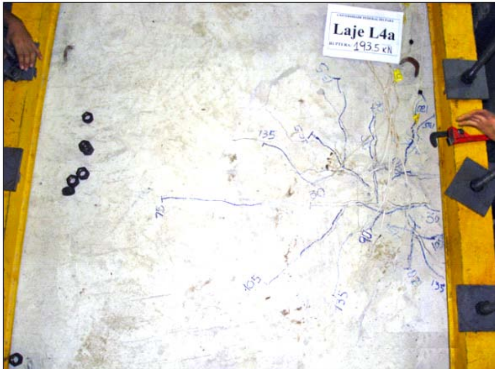
Figura 4.40 – Mapa de fissuração da laje L4a
