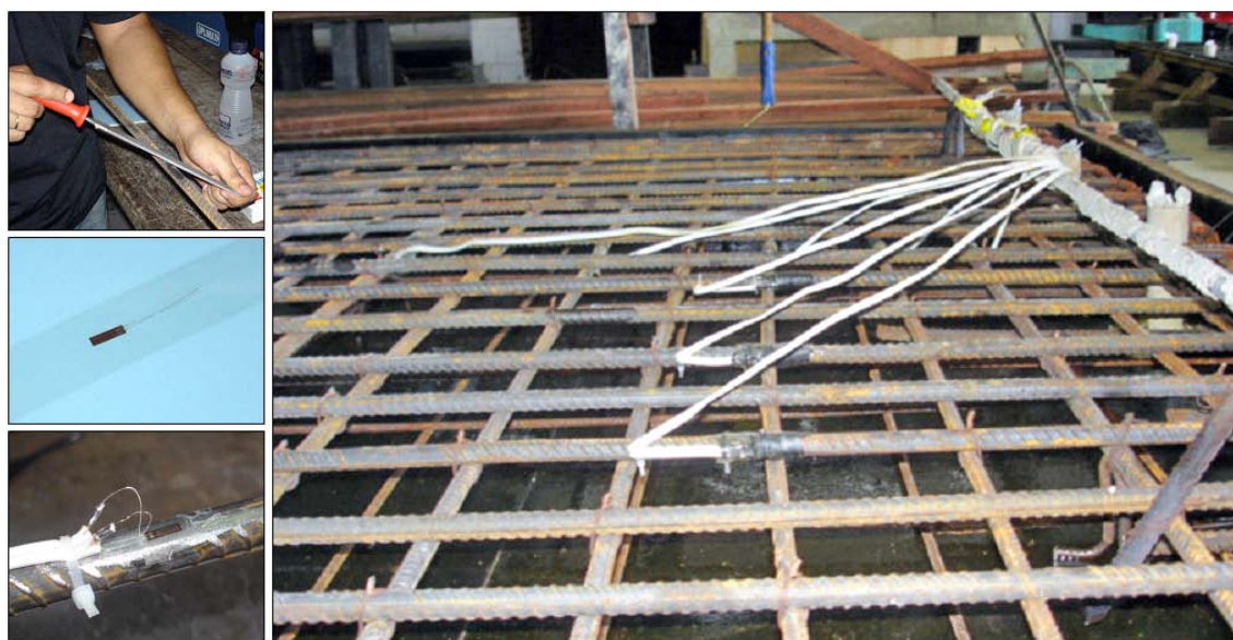
Figura 3.10 – Detalhes do monitoramento das armaduras
