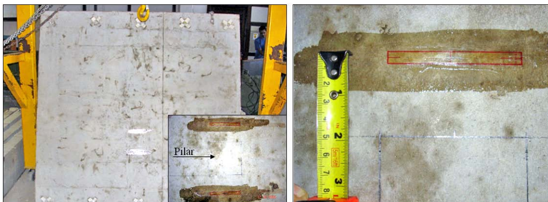
Figura 3.9 – Monitoração das deformações do concreto na superfície inferior das lajes
