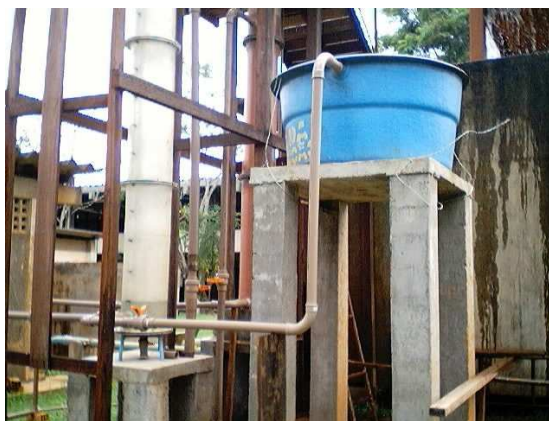
Fotografia 22 - Base de sustentação de concreto da caixa d'água da ETA-Piloto. Fonte: Direta.
