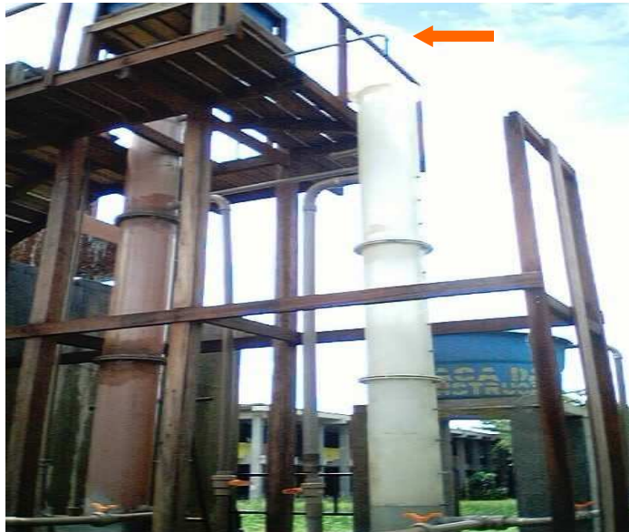
Fotografia 24 - Tubulações de entrada do filtro sem passar pelo leito de contato Fonte: Direta
