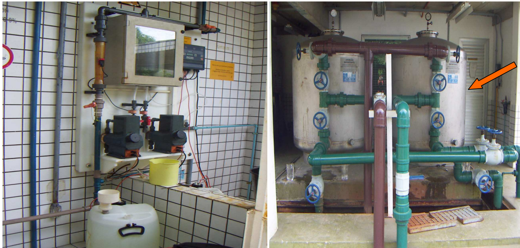
Fotografia 8 - Painel de controle de adição de dióxido de cloro e filtro de pressão da ETA Infraero Fonte: Direta
