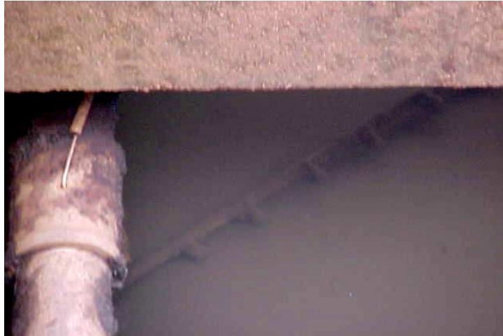
Figura 21 - lavagem superficial com torniquetes hidráulicos Fonte: Direta
