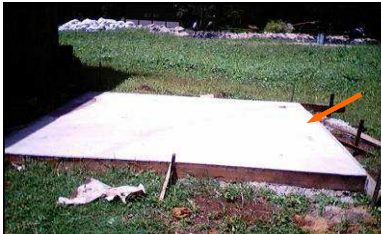
Fotografia 18 - Base de concreto para implantação da ETA-Piloto. Fonte: Direta.
