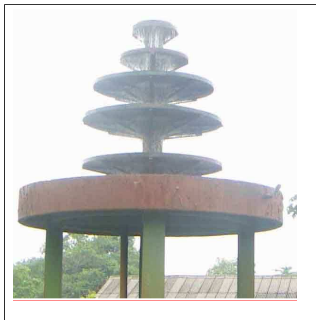
Fotografia 3 - Aerador Tipo Cascata Fonte: Lopes (2004)
