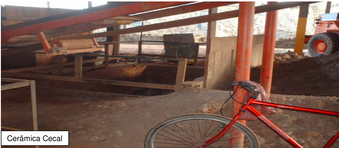
Foto 02: Caixão alimentador (Março, 2007).
