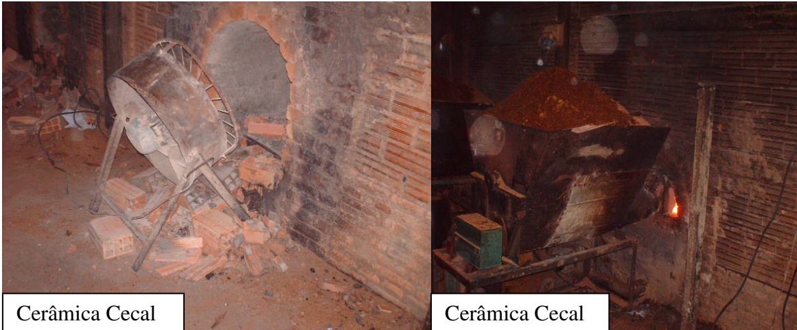
Foto 09: Entrada do forno, e abastecimento da boquilha com serragem (Março, 2007).
