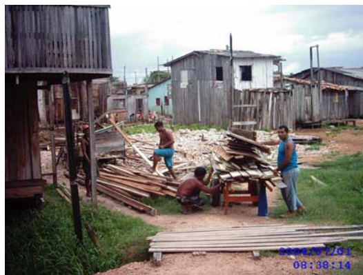
Figura 21 - Demolição das moradias no Riacho Doce. Foto da autora. Março/2005
