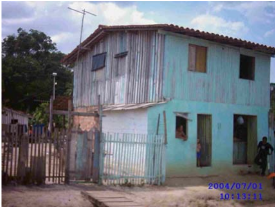
Figura 63 - Fachada da moradia atual em Marituba . Novembro / 2005
