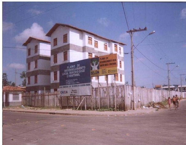
Figura 42 – Fachada do prédio da 2ª proposta Fotos da autora. Março/2005
