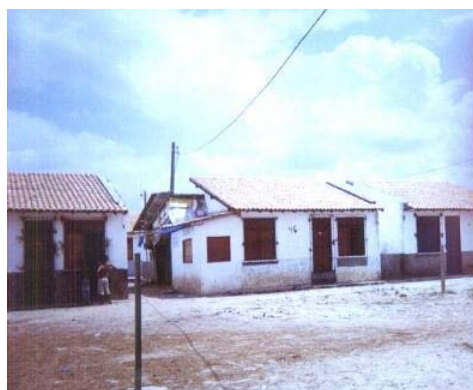
Figura 57 – Moradia ampliada no Pantanal II. Fotos da autora. Novembro/2005
