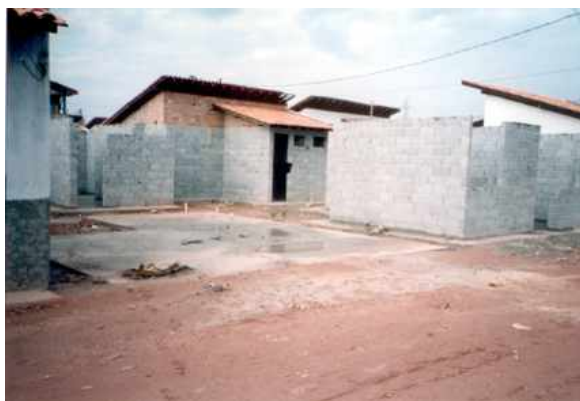
Figura 22 - Início da construção das unidades sanitárias no Pantanal. Foto da autora. Março/2005
