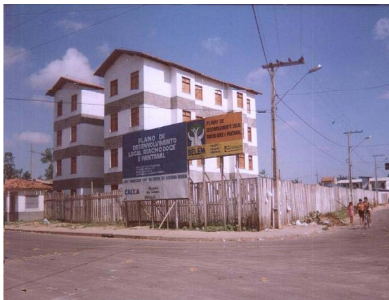
Figura 78 - Bloco de Apartamentos. Foto da autora. Dezembro/2005
