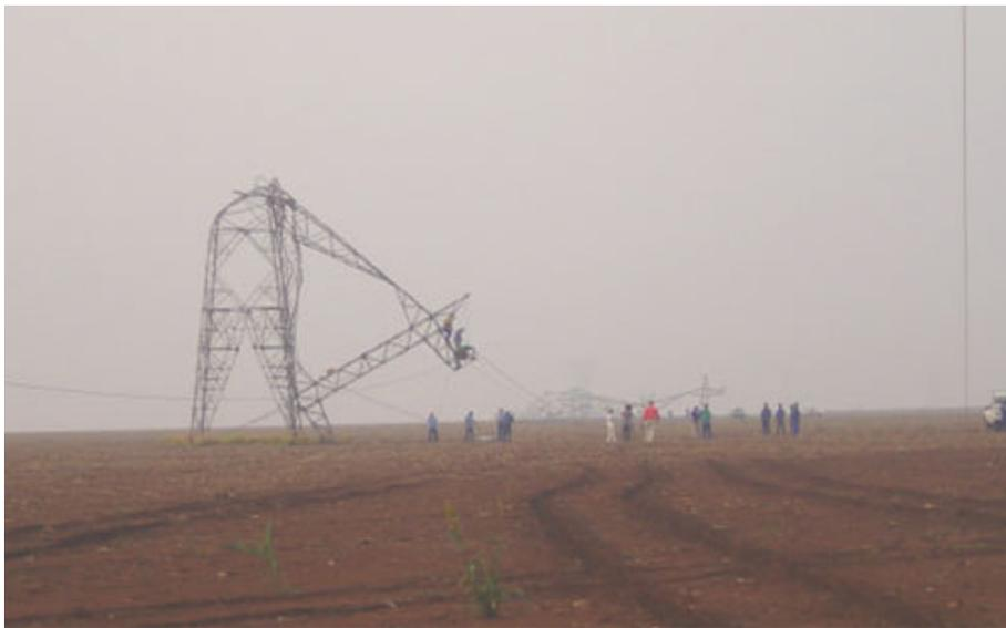
Figura 1-2 – Torre 196 colapsada componente da LT de 230 KV Caxipó/Sinop no Estado do Mato Grosso (Caldas, 2004)
