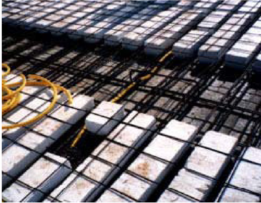
Figura 3 - Laje unidirecional (Pinheiro e Rezente, 2003)
