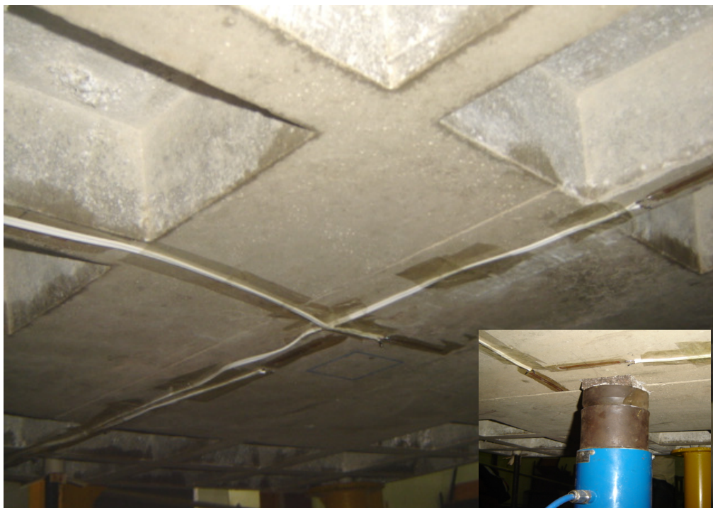
Figura 54 - Detalhe dos extensômetros fixados na laje
