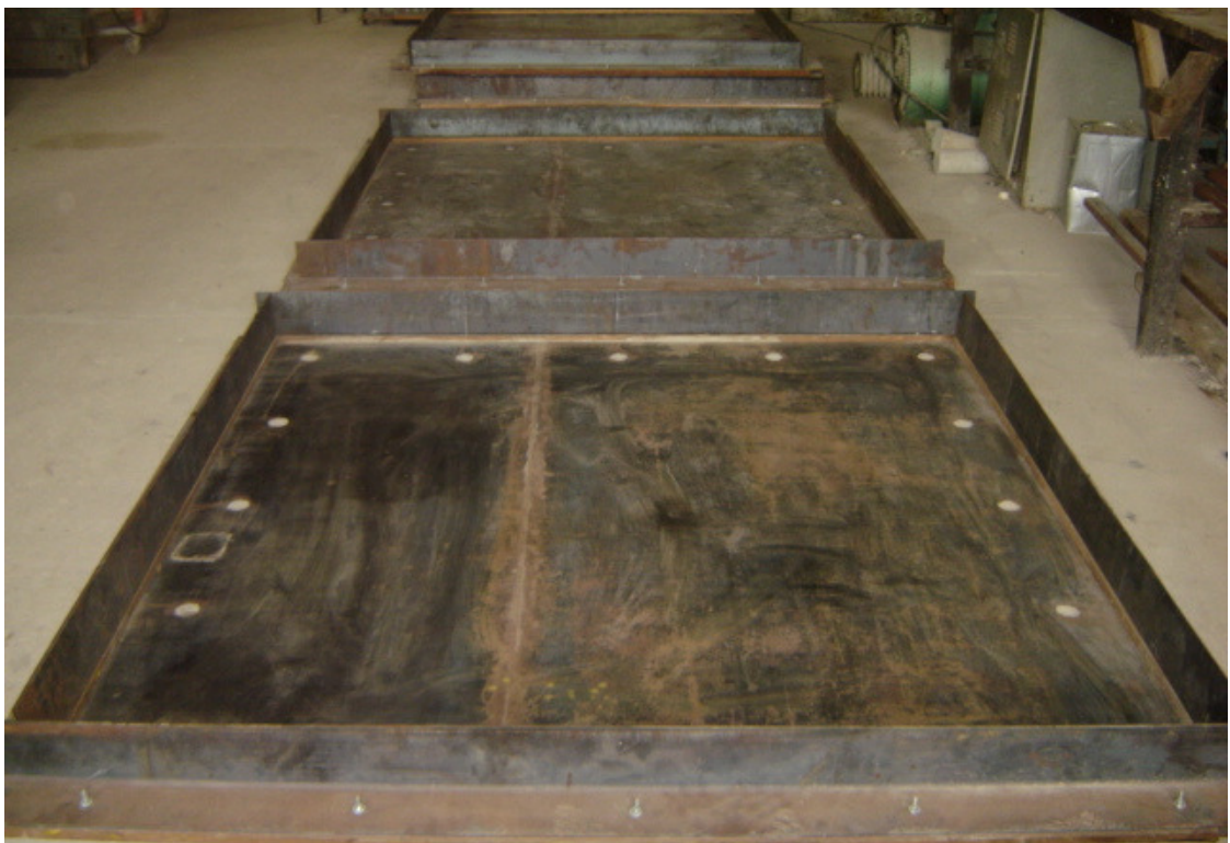
Figura 65 - Formas metálicas utilizadas na confecção das lajes
