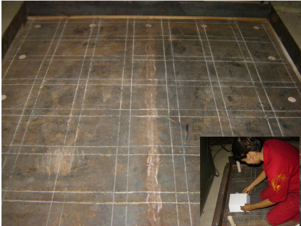
Figura 66 - Marcação e detalhe da fixação dos blocos de EPS
