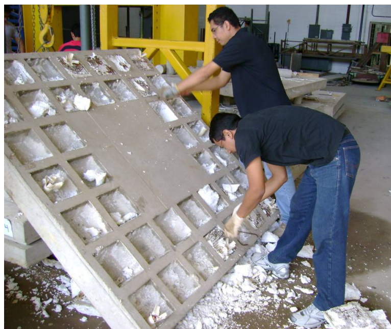
Figura 72 - Retirada dos blocos de EPS
