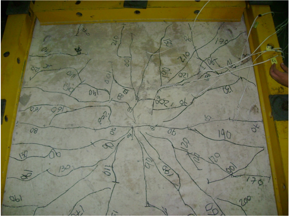
Figura 133 - Padrão de fissuração da laje L4
