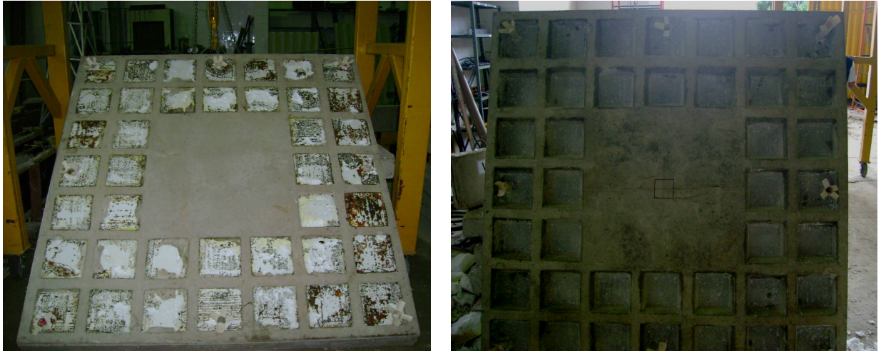
Figura 73 - Vista da parte inferior da laje antes e após a retirada dos blocos de EPS
