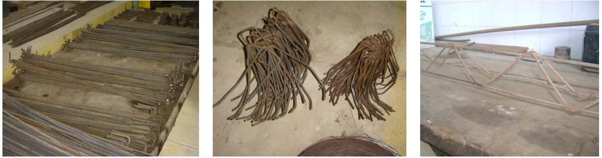
Figura 64 - Armaduras utilizadas nas lajes
