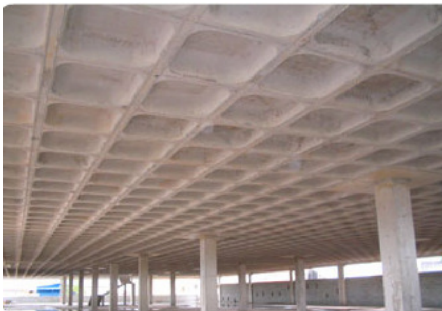
Figura 29 -Pavimento em laje lisa nervurada (www.atex.com.br)
