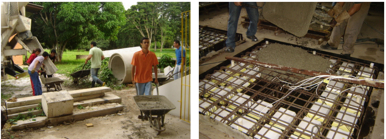
Figura 68 - Transporte e lançamento do concreto na fôrma
