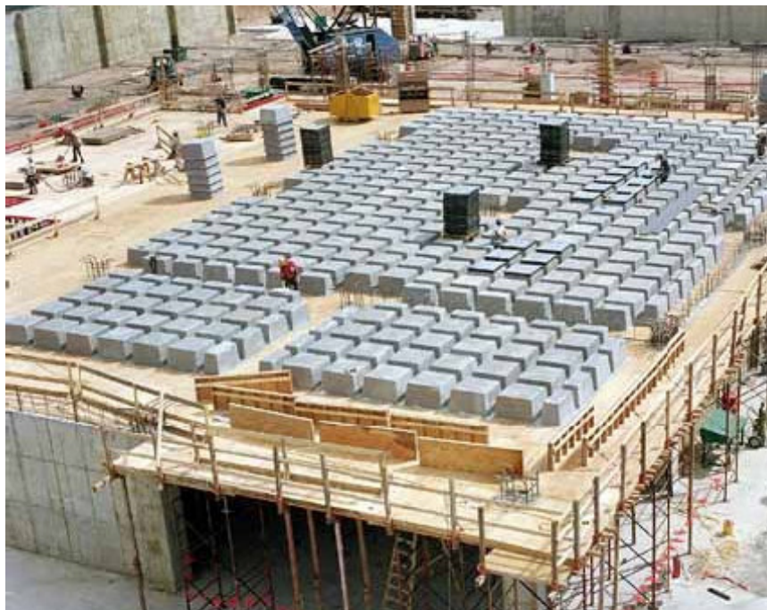
Figura 4 - Laje bidirecional (Dias, 2003)
