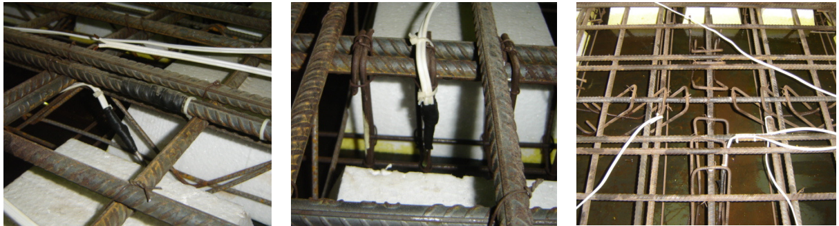
Figura 62 - Detalhe do monitoramento das armaduras de cisalhamento
