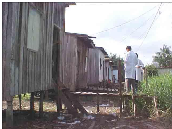
Fotografia 19 – Ponto 6, Travessa São João Fonte: Direta (2006)
