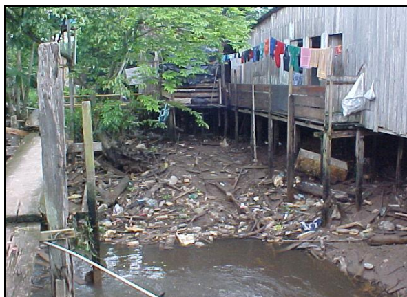
Fotografia 49 – Acúmulo de resíduos sólidos nas margens do igarapé Mata Fome. Fonte: Direta (2006)
