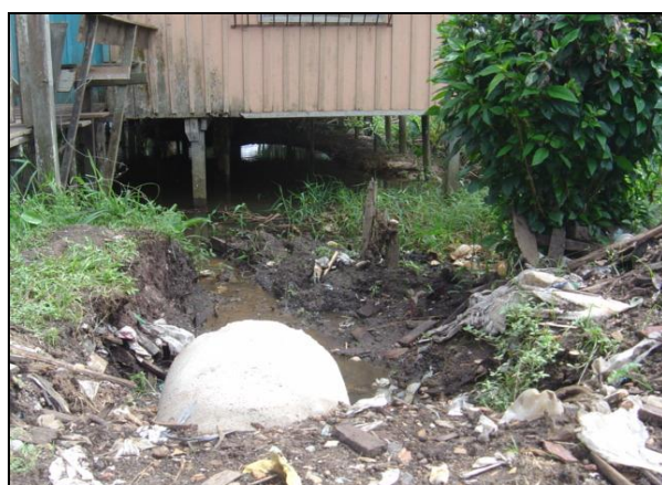
Fotografia 39 – Instalação de tubulações de drenagem na bacia Mata Fome. Fonte: Direta (2006)
