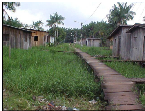
Fotografia 36 – Construção de estivas, Bacia do Mata Fome Fonte: direta (2006)
