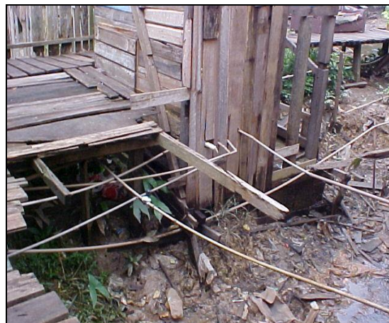
Fotografia 32 – Distribuição de água improvisada, Bacia do Mata Fome. Fonte: Direta (2006)
