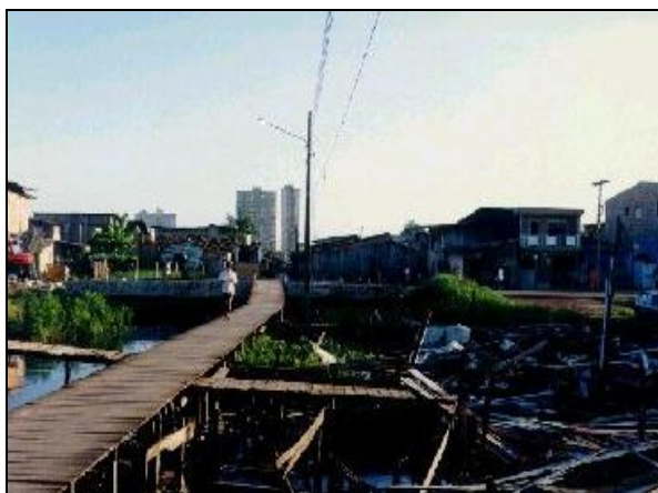
Fotografia 1 – Canal da Visconde de Inhaúma, antes da intervenção urbanística na Bacia do Una.
