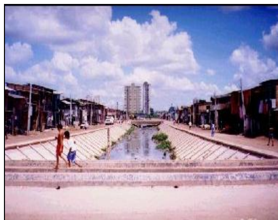
Fotografia 2 – Canal da Visconde de Inhaúma, depois da intervenção urbanística na Bacia do Una.
