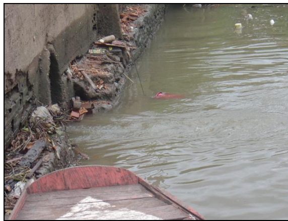
Fotografia 38 – Tubulação de drenagem a jusante da Rodovia Arthur Bernardes. Fonte: Direta (2006)
