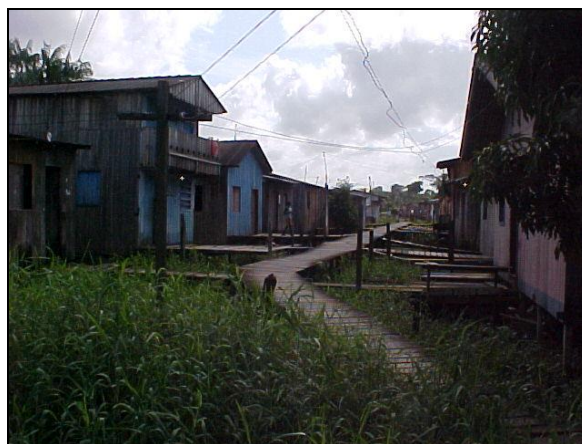
Fotografia 42 – Construção de casas nas margens do igarapé. Fonte: Direta (2006)
