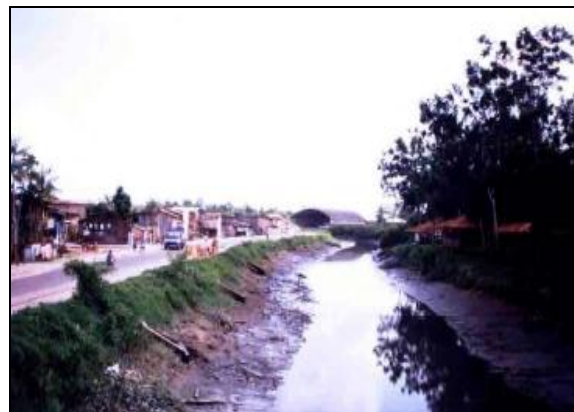
Fotografia 4 – Igarapé Tucunduba, depois da intervenção urbanística. Fonte: Lisboa e Mello (2003)
