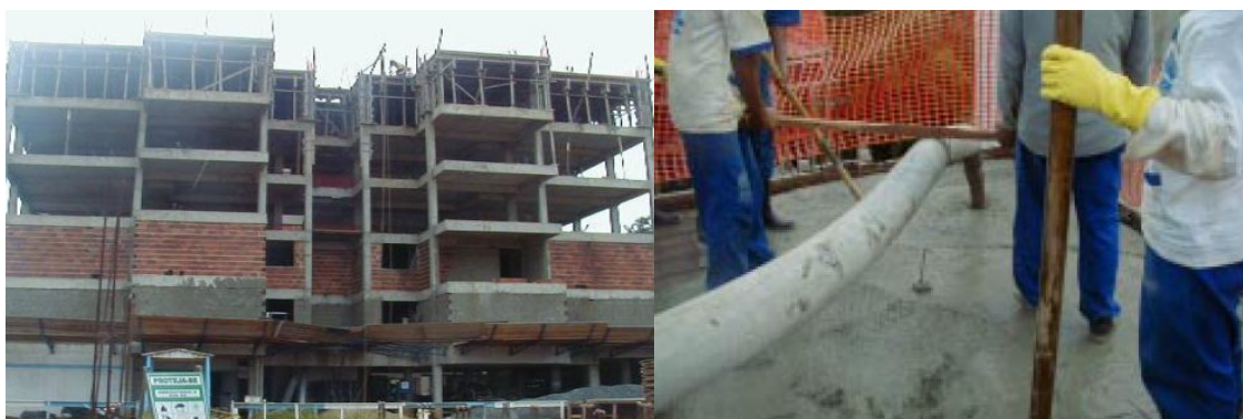
Figura 2.2 – Detalhe geral da estrutura e da concretagem do Edifício Camila em Goiânia. Fonte: Geyer (2005).
