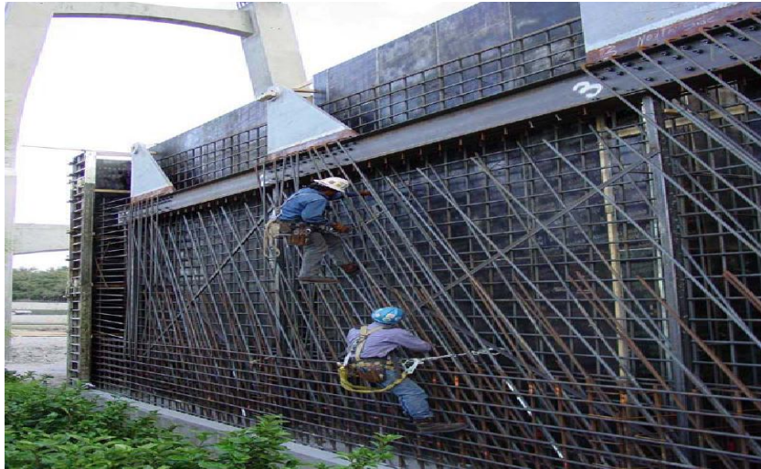
Figura 2.6 – Utilização do CAA em passarela na Flórida EUA (2004), detalhe da armação. Fonte: ABESC (2006).
