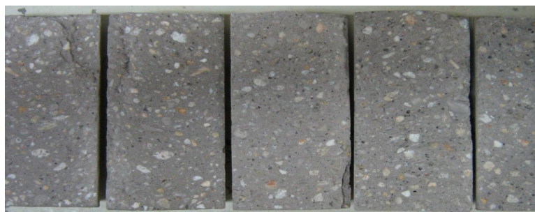
Figura 4.14 – Distribuição uniforme dos agregados graúdos no CAA 01 (traços 1:2, 1:3, 1:4, 1:5 e 1:6, da esquerda para a direita).
