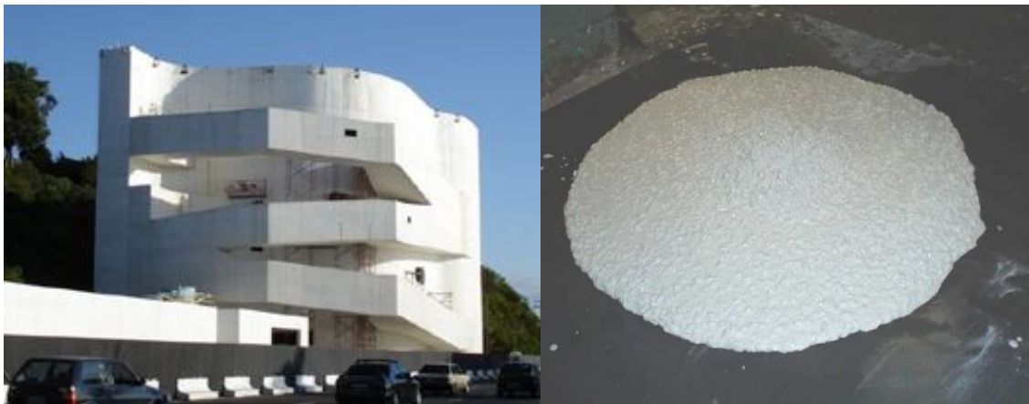
Figura 2.7 – Detalhe da fachada do Museu Iberê Camargo e do CAA branco usado na sua construção. Fonte: Silva Filho et al. (2004).
