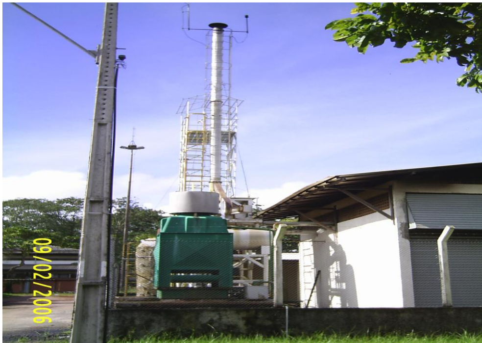
Fotografia 5: Sistema de resfriamento da usina do EBMA.
