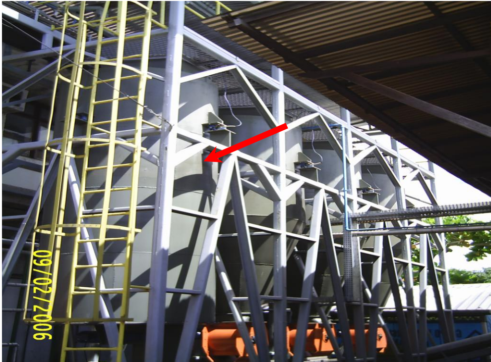
Fotografia 2: Silos que recebem a biomassa.
