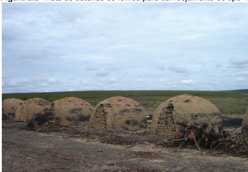
Figura 2.5- Vista de baterias de fornos para carvoejamento do tipo “rabo quente”.
