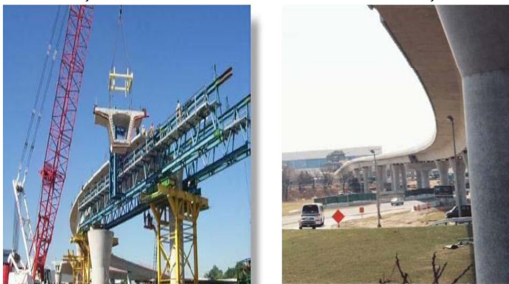
Figura 3.6- Construção e obra finalizada com escória de alto-forno em substituição ao cimento.
