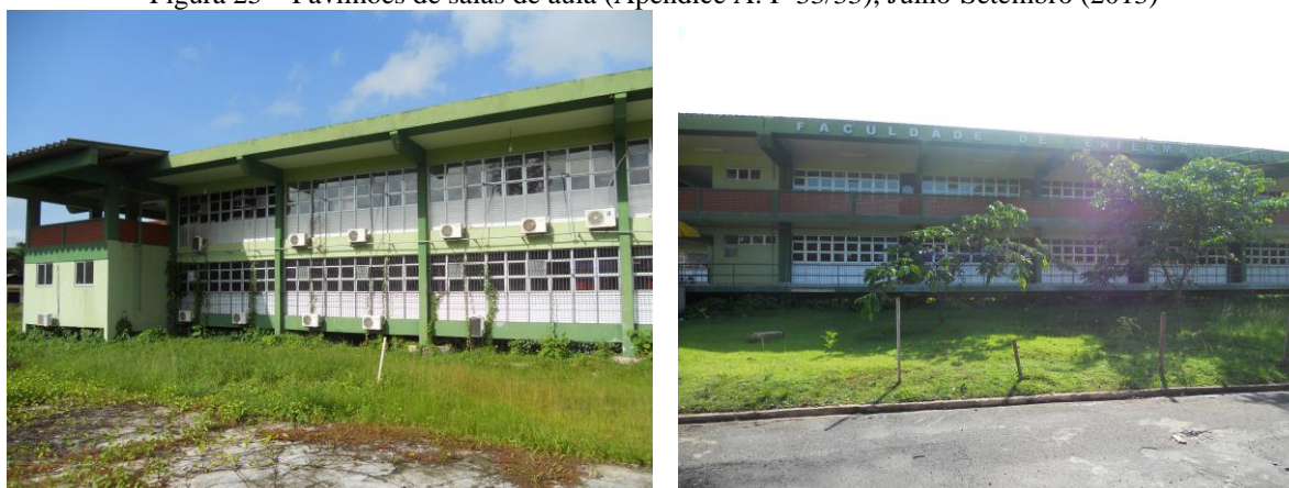
Figura 25 – Pavilhões de salas de aula (Apêndice A: F-33/33), Julho-Setembro (2013)
