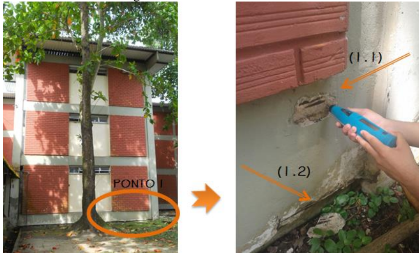
Figura 40 – Ponto 1 – Fachada A
