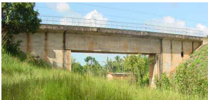
Figura 4.1 – Vista geral do Viaduto sobre a CFN 1ª travessia (VALE, 2003)
