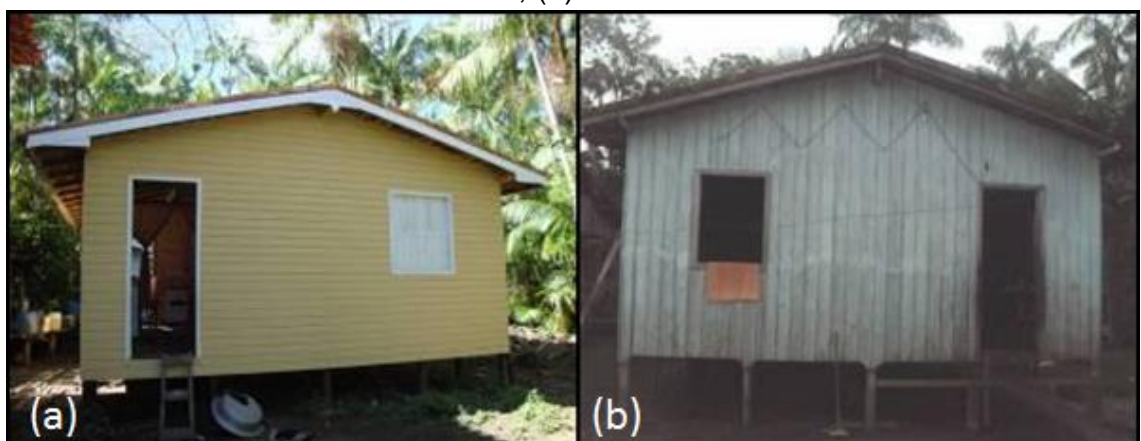
Figura 15 - Locais onde os sistemas rurais (SAC R1 e R2) foram instalados: (a) Residência na Ilha Grande; (b): Residência na Ilha Murutucu.
