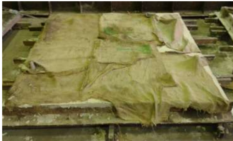
Figura 3.18 – Procedimento de cura das lajes.
