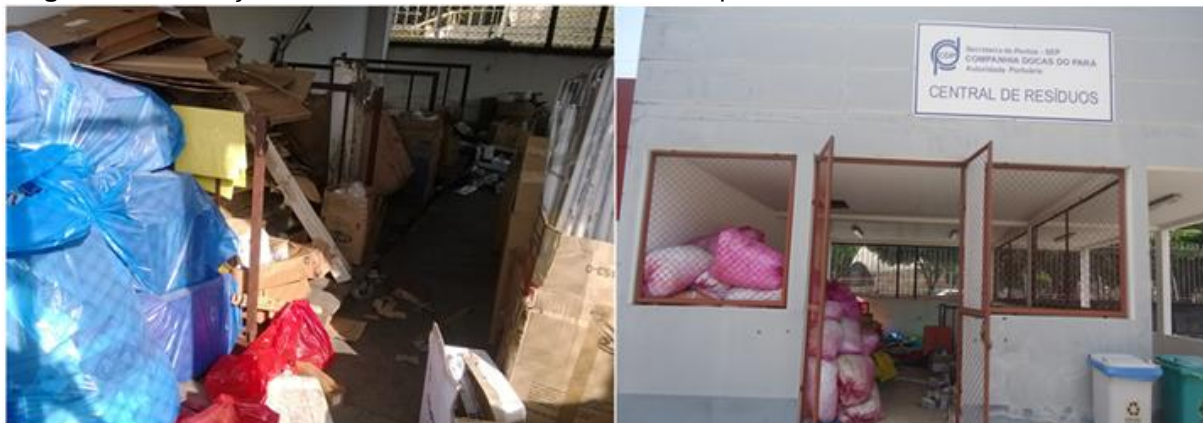
Figura 55 - Condições da Central de Armazenamento Temporário de Resíduos do Porto de Belém.
