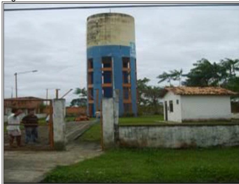
Figura 17 – Reservatório elevado do SAA Baía do Sol.
