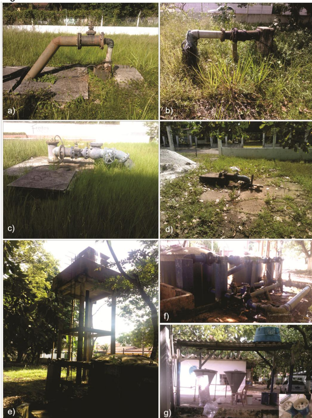
a) poço 1; b) poço 2; c) poço 3; d) poço 4; e) ETA simplificada (aeração para remoção de ferro); f) reservatórios apoiados e g) casa de química.
