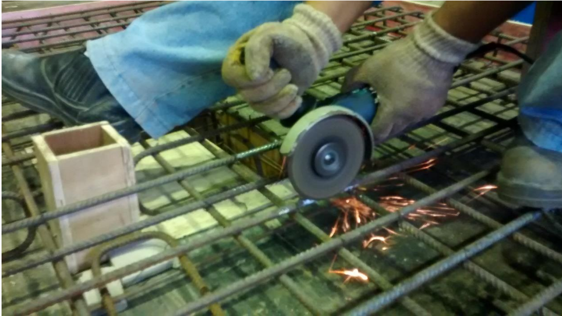
Figura 4.26 – Regularização da superfície
