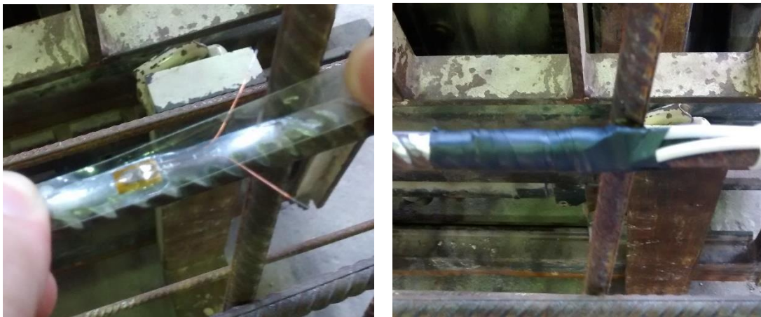
Figura 4.27 – Fixação dos extensômetros nas barras
