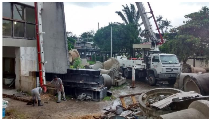
Figura 4.38 – Bomba lança utilizada durante a concretagem
