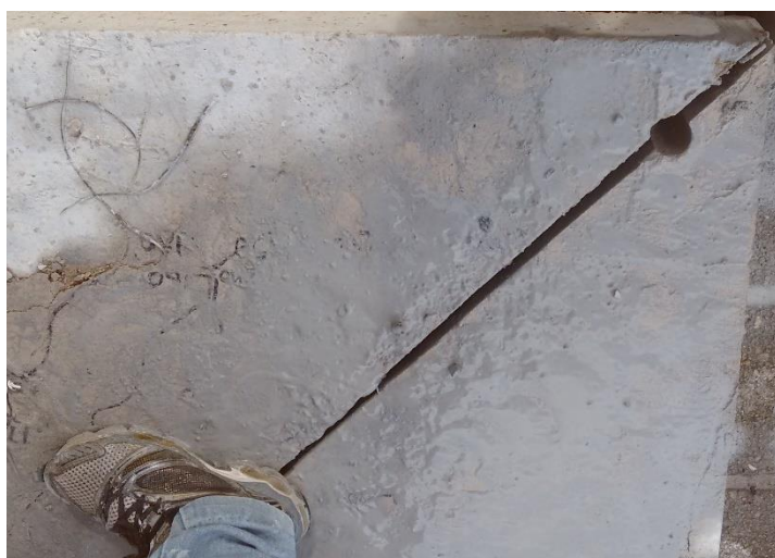
Figura 5.27 – Laje após o corte da superfície superior
