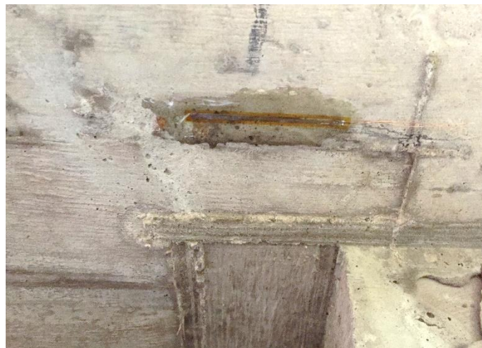
Figura 4.31 – Extensômetro do concreto
