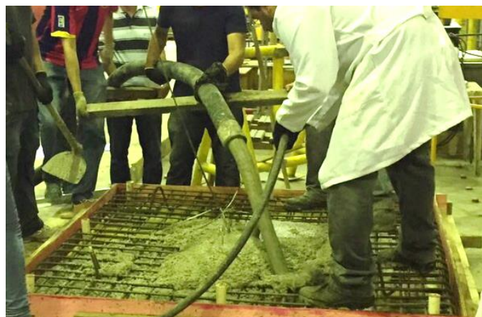
Figura 4.39 – Lançamento do concreto na laje
