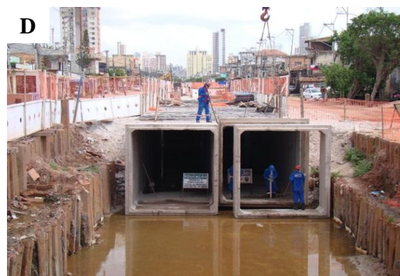
Canal fechado com aduelas
