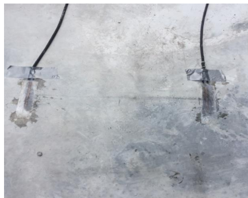
Figura 78 - Aplicação de Silicone
