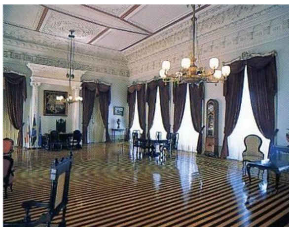
Figura 5 - Amostra de Piso de Acapu e Pau Amarelo - Palácio Antônio Lemos - Belém - Pará
