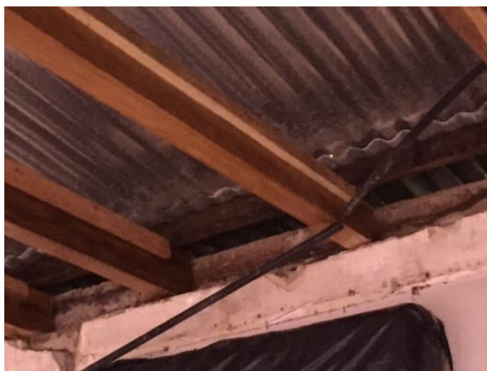
Figura 62 - Colocação das Peças para Chumbamento
