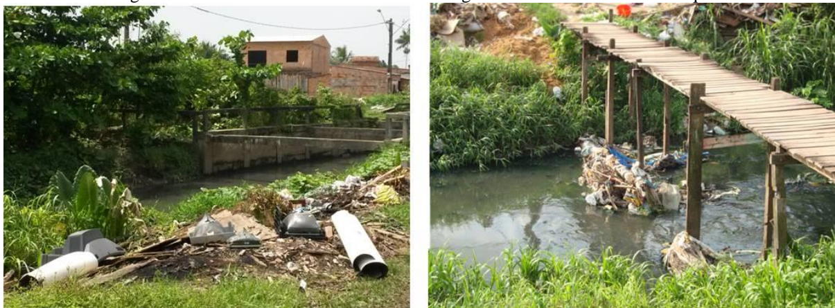
Figura 4: Resíduos sólidos observados nas margens e dentro do canal São Joaquim.
