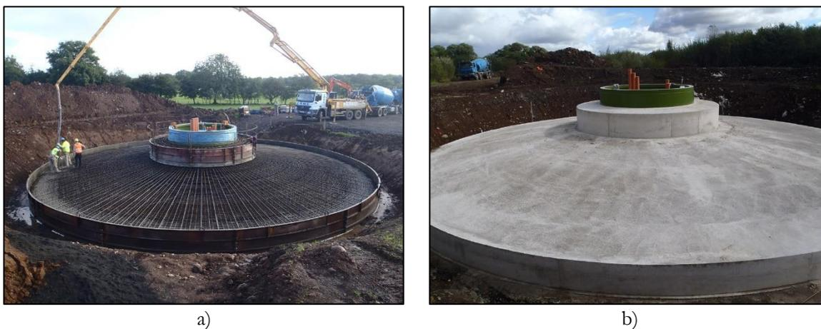
Figura 1.3 – Exemplos do uso de sapatas como fundação em grandes estruturas
