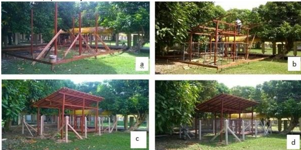
Figura 8 – Fotografias das etapas da construção da UETAC: a) locação de obra e construção de estrutura (pilares); b) construção do madeiramento do telhado; c) construção da cobertura; d) construção da cerca metálica.
