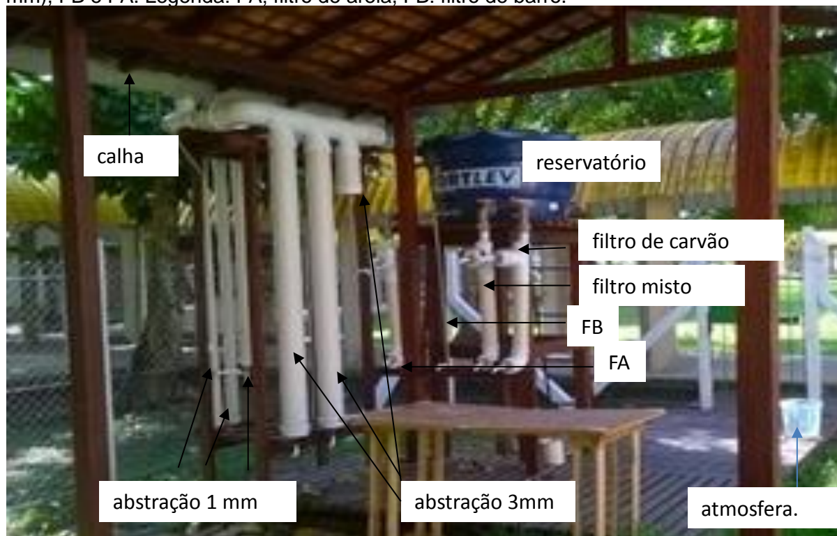
Figura 6 – Fotografia da UETAC com identificação dos pontos de amostragem desta pesquisa: atmosfera, calha, abstração 1 mm, abstração 3 mm, reservatório (abstração 4 mm), FB e FA. Legenda: FA; filtro de areia, FB: filtro de barro.
