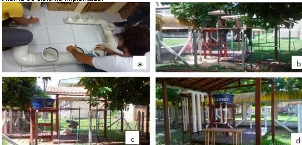
Figura 9 – Fotografias das instalações hidráulicas da UETAC: a) montagem das abstrações; b) instalação das abstrações; c) instalação do reservatório de água; d) vista interna do sistema implantado.
