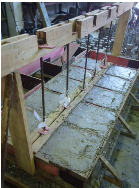
Figura 3.8 – Concretagem dos espécimes.
