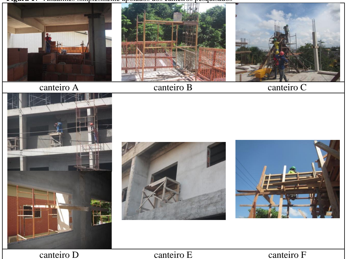
Figura 17- Andaimos simplesmente apoiados dos canteiros pesquisados
