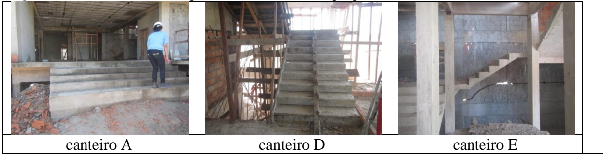
Figura 12- Corrimão das escadas permanentes dos canteiros pesquisados
