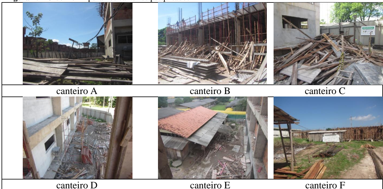
Figura 25 - Ordem e limpeza nos canteiros pesquisados
