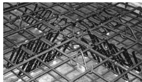
c) Exemplo: armadura da laje PSSB
