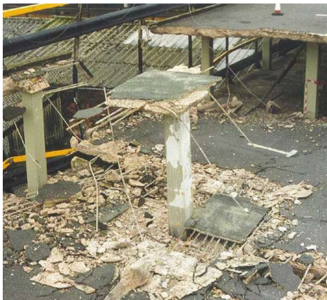
a) Edifício Piper Rows Car Park , Wolverhampton, Inglaterra (WOOD, 1997)
