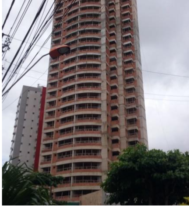
Figura 30: Vista frontal do Edifício A.
