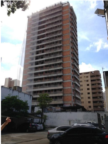
Figura 33: Vista lateral direita do Edifício B
