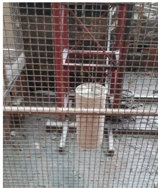
Figura 46: Pêndulo para estabilização da linha de prumada.
