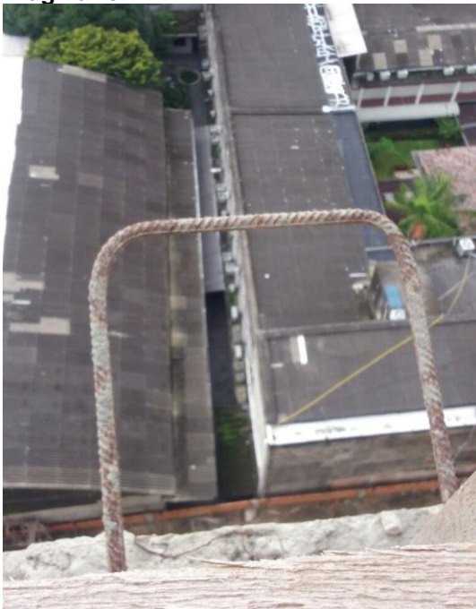
Figura 45: Gabarito em "U", locação do eixo imaginário.
