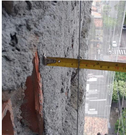
Figura 37: Medição do controle na trena no Edifício A
