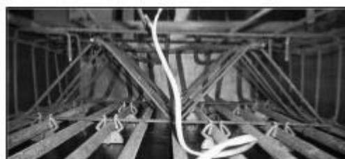
b) Estribo W montado na viga
