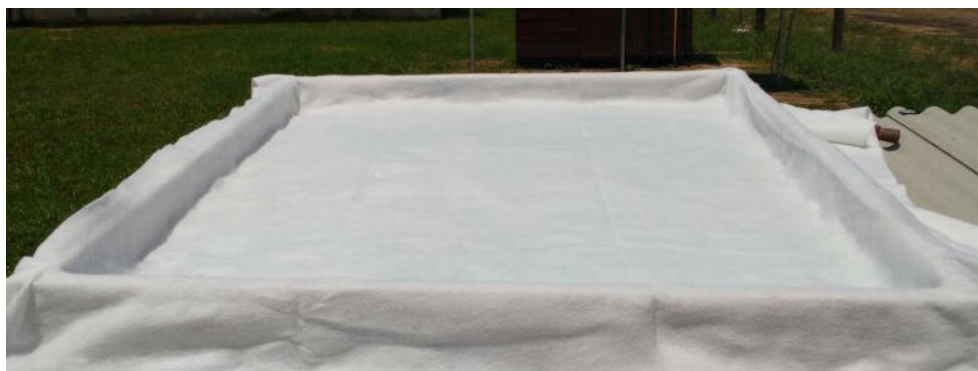
Figura 12: Camada filtrante manta geotêxtil.
