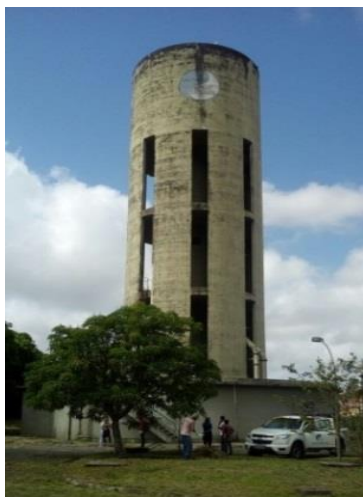
Figura 34. Vista do reservatório elevado.
