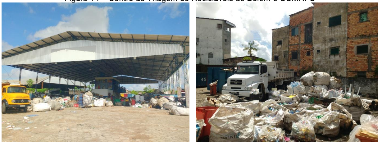
Figura 14 – Centro de Triagem de Recicláveis de Belém e CCMRFS
