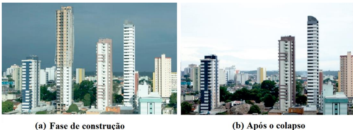
Figura 5.1 - Edifício Real Class (Construção e Pós-Colapso)
