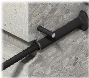
b) Ligações entre painéis pré-moldados de concreto
