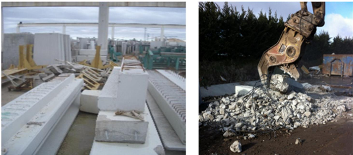
Figura 1-1 - Aterro de resíduos para concreto pré-moldado e processo de demolição para descarte (FIOL et al. , 2018)
