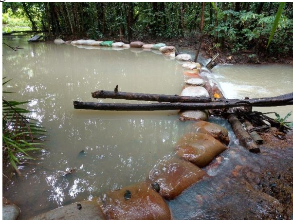
Figura 11. Barramento construído com ensacadeiras.
