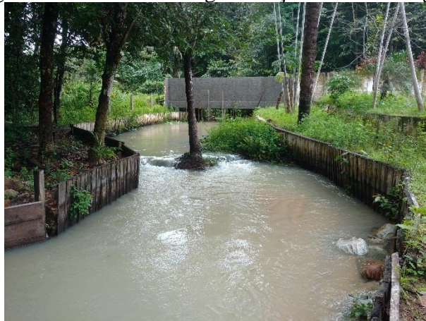
Figura 19. Trecho com regularização do curso d'água.
