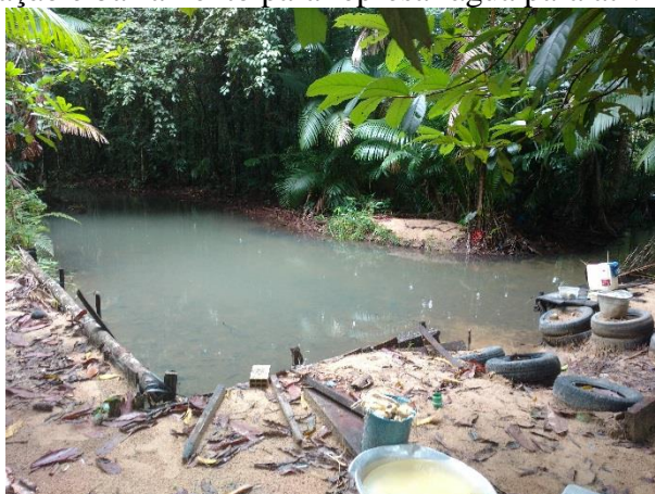
Figura 15. Escavação e barramento para represar água para atividades domésticas.
