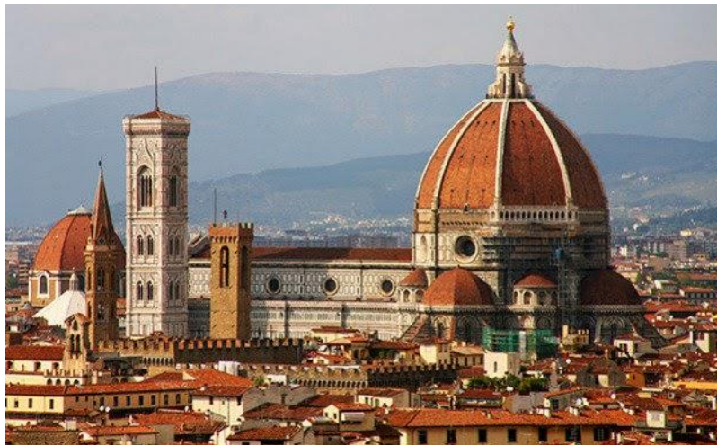
Figura 10- Catedral de Florença-Itália (Cobertura em tijolos, cerâmicas recolocadas em escama). Fonte: http://arteeducacaodf.blogspot.com.br
