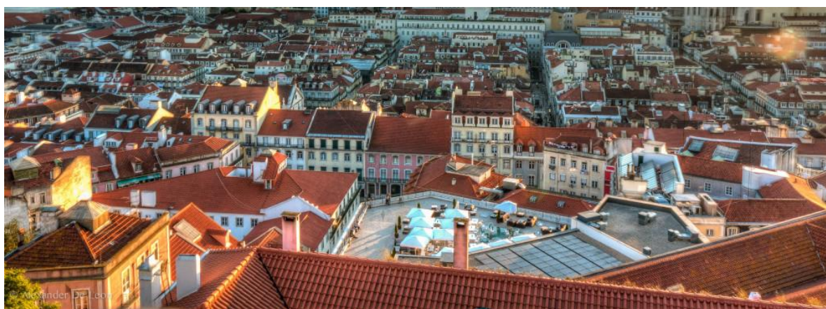
Figura 16- Coberturas com telhas de cerâmica, muito utilizadas em residências. Fonte: http://brasiliaconcreta.com.br
