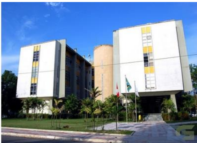
Figura 49- Prédio da reitoria da UFPA, campus básico ( www.ufpa.br ).
