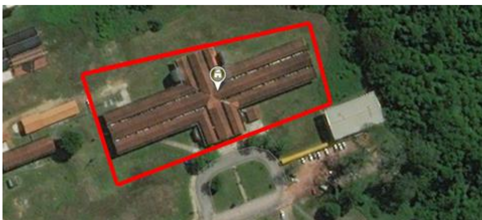
Figura 57 - Vista aérea Hospital Bettina Ferro De Souza (Fonte: software RETScreen Expert).
