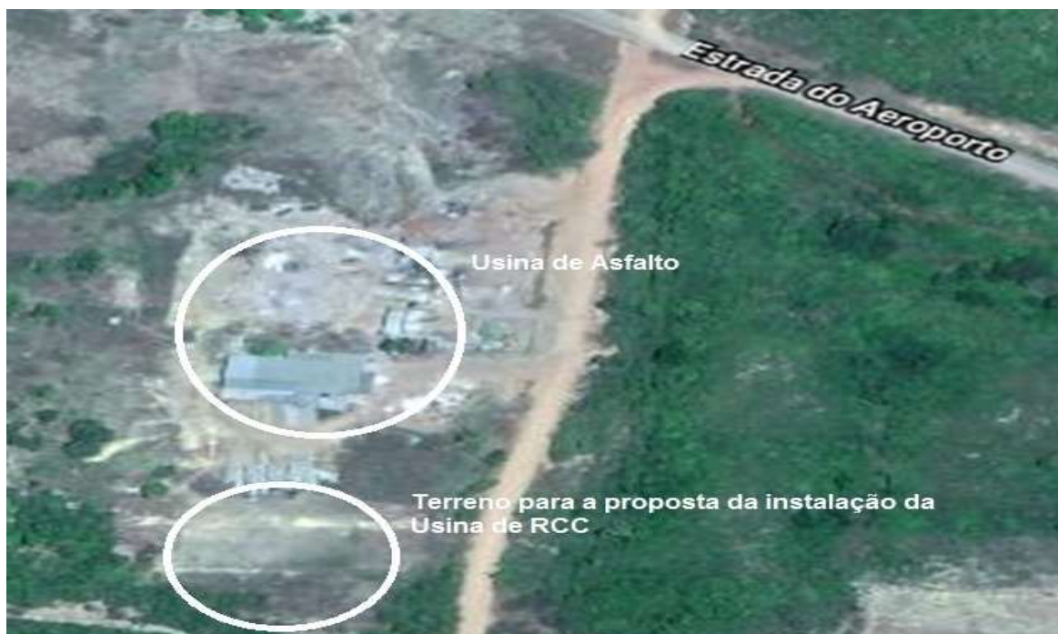
Figura 16- Localização do terreno para instalação da usina de reciclagem
