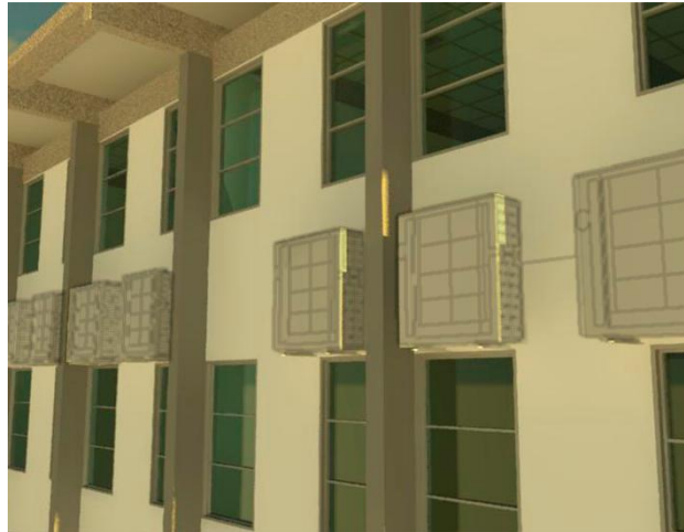
Figura 4.31 - Fachada Norte do prédio com aparelhos padronizados.
