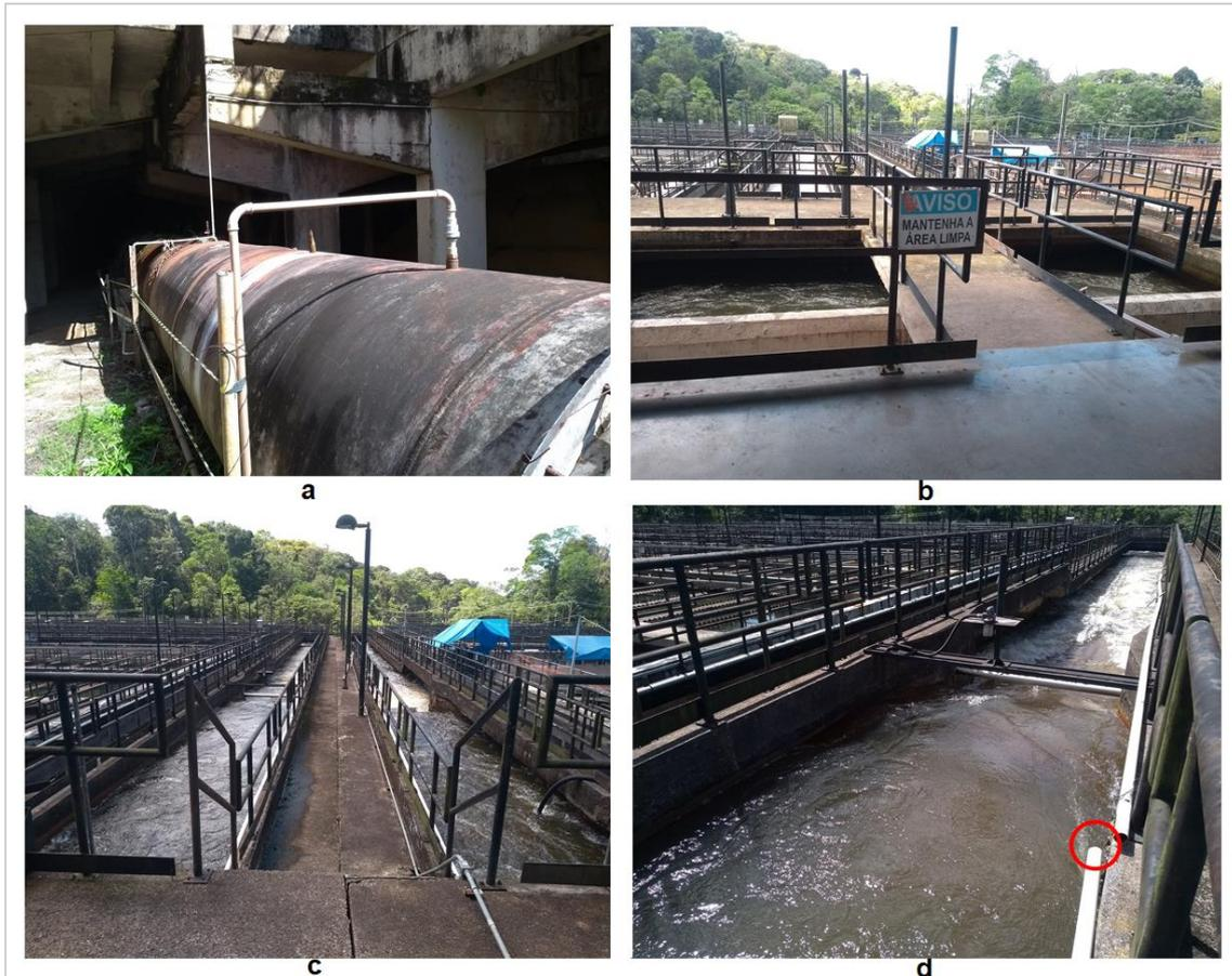
Figura 15 - Ponto de aplicação do coagulante – PAC (a), câmara de chegada (b), calhas Parshall (c) e ponto de aplicação do polímero de poliacrilamida (d).
